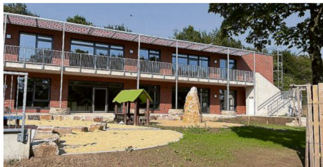
So sieht die neue DRK-Kita an der Fritz-Erler-Straße in Hertener-Disteln von außen derzeit aus. Sie steht kurz vor der Eröffnung. FOTO OLIVER PRAUSE
